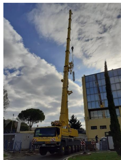
Figura 14, figura 15: Ponte Galeria, Roma, Centro Interforze. Installazione CTA sulla copertura.
