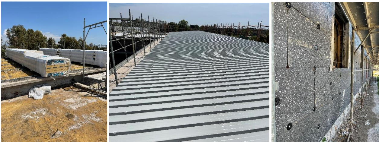
Figura 18, figura 19, figura 20: Pratica di Mare, fabbricati alloggi A.M. Coibentazione copertura e pareti.
