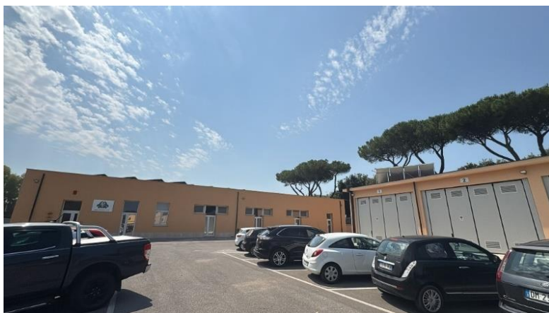
Figura 7, figura 8, figura 9: Roma, caserma "Ettore Rosso" post intervento.
