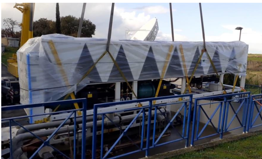
Figura 14, figura 15: Ponte Galeria, Roma, Centro Interforze. Installazione CTA sulla copertura.
