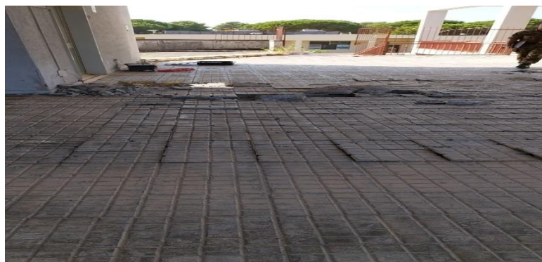
Figura 10, figura 11, figura 12: Serre, caserma “Capone”. Facciata palazzina e terrazzo ante intervento.
