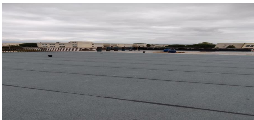
Figura 13: Serre, caserma “Capone”. Post intervento: cappotto lastrico con esalatori.
