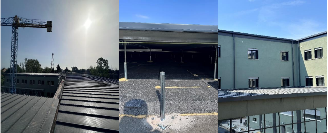
Figura 21, figura 22, figura 23: Treviso, fabbricati alloggi A.M. Coibentazione copertura e pareti.
