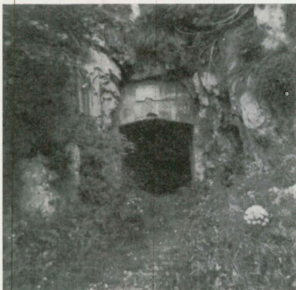
INGRESSO DI UNA POSTAZIONE IN CAVERNA SUL MONTE CENGIO
